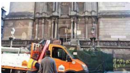
Tret de sortida a les obres de millora de la façana de l'església de Sant Esteve d'Olot DV, 17/01/2020 | DIARI DE GIRONA
