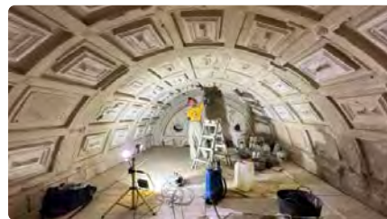
Comencen les obres dels revestiments de la Capella del Castell dels Icart de Torredembarra DV, 27/01/2023 | LA CIUTAT
